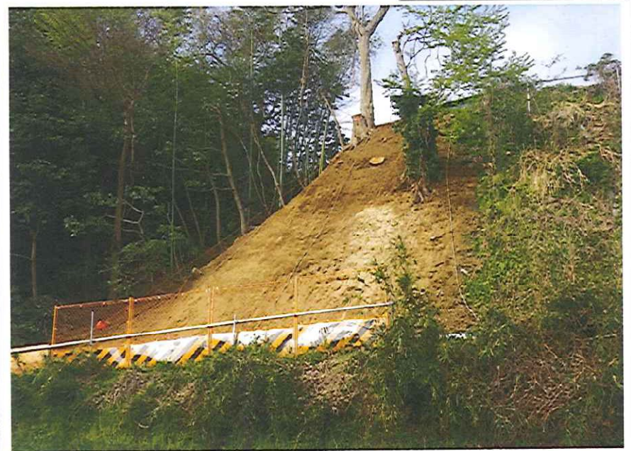
現況地形を残した 法面整形完了
