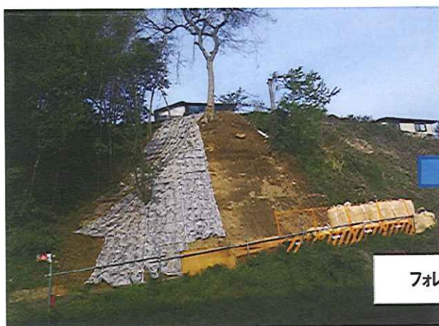
平成25年4月施工 縦通りのアンカーφ400mmを打込み
