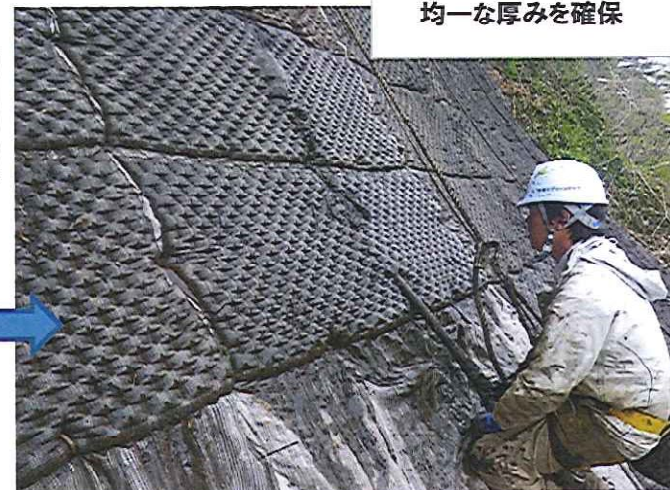
客土注入完了で 均一な厚みを確保
